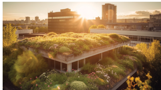
Mocnější vegetační souvrství může na střeše zadržet velké množství vody, foto: Freepik.com.
